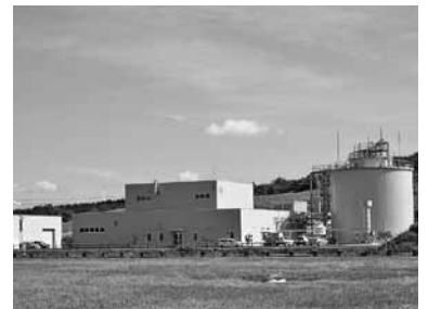
生ごみ中間処理施設、バイオエネルギーセンター
