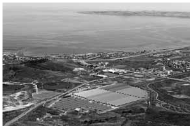
東京ドームの約3倍の広さを誇る稚内メガソーラー発電所（写真提供：明電舎）
