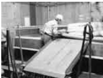
人力による水蓄熱水槽への投入状況
