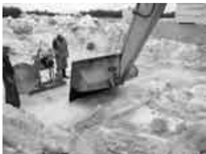
専用切り出し機と鋸歯バックホウによる氷切断状況
