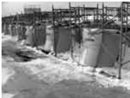
フレコンバックによる製氷状況
