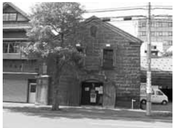
倉庫改造のレストラン
