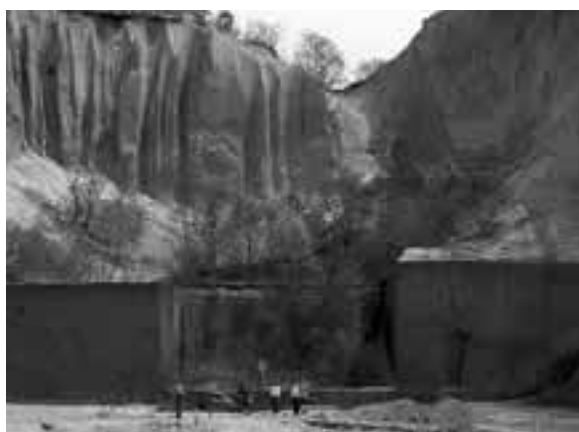
ネガティブマウンド工事着手前
