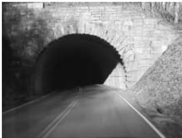
BRPのトンネル（自然石の坑門）
