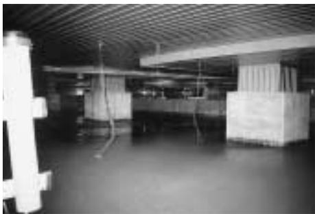
年間水畜熱空調システムのための地下の水貯蔵庫
