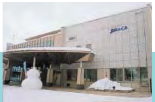
雪冷房の導入と雪室が併設された生涯学習総合センター「ゆめつくる」
