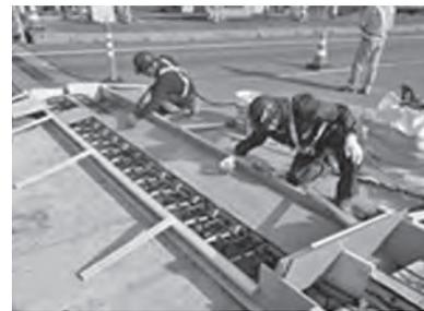
構造物の修繕（伸縮装置補修）
