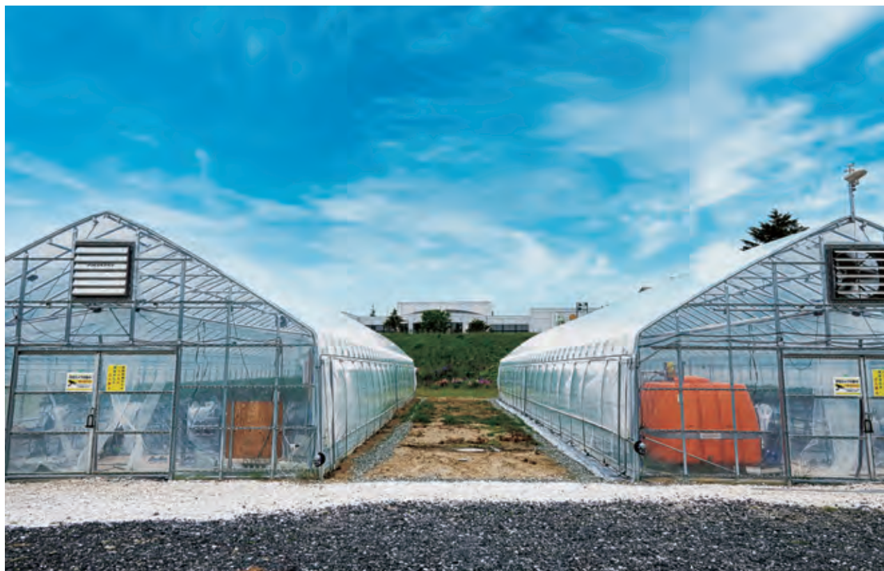
写真－11 グラウンドに設置された2棟のビニールハウス。中央奥が旧芦野小学校校舎
