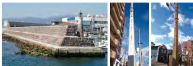
函館漁港船入潤防波堤（北海道唯一の石積み構造の防波堤、コンクリートブロックとのハイブリット構造）
