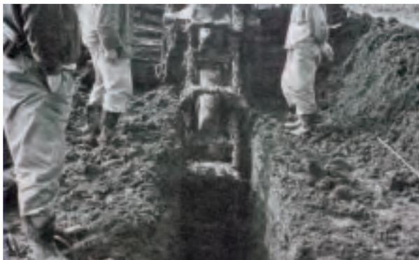
トレンチャーによる暗渠の掘削状況
