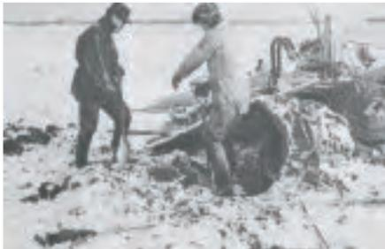
篠津原野の泥炭地で作業中に自重で沈んだブルドーザ
