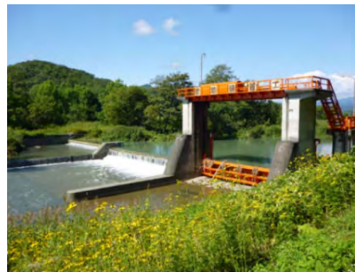
写真-2 歌笛頭首工全景
