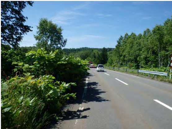
写真-1 イタドリによる視距障害 (国道275号)
