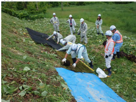
写真-3 試験施工の様子
