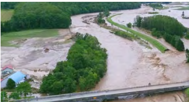
写真-1 アクセス不可能な地域で発生した堤防決壊
