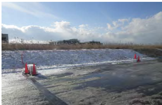
写真-3 設置状況
