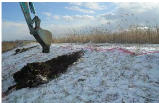
写真-4 杭の周辺を掘削
