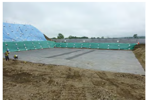
写真-2 カルバート基礎補強工の施工状況 (No. 2 ボックスカルバート)
