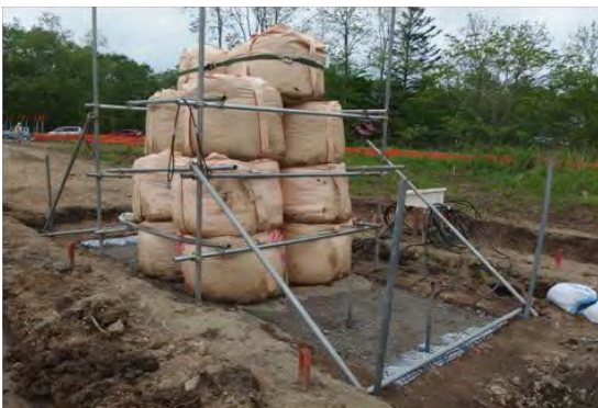
写真-1 フィールド試験状況写真
