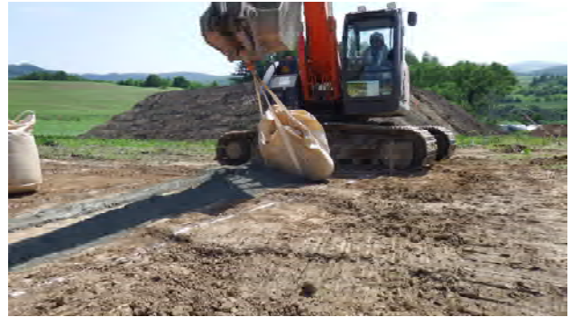
写真-1 セメント固化材敷均し
