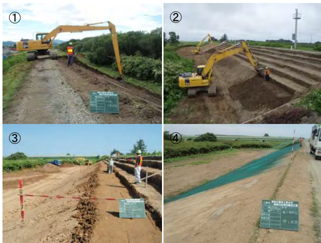
図 2-1 オオイタドリ対策工の施工手順 H20 施工 湧別川 湧別右岸築堤での施工時
