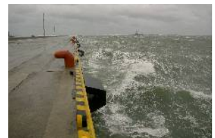
写真-3 港内擾乱状況
