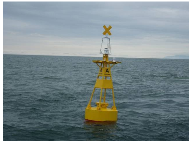
写真-5 浮標灯設置状況
