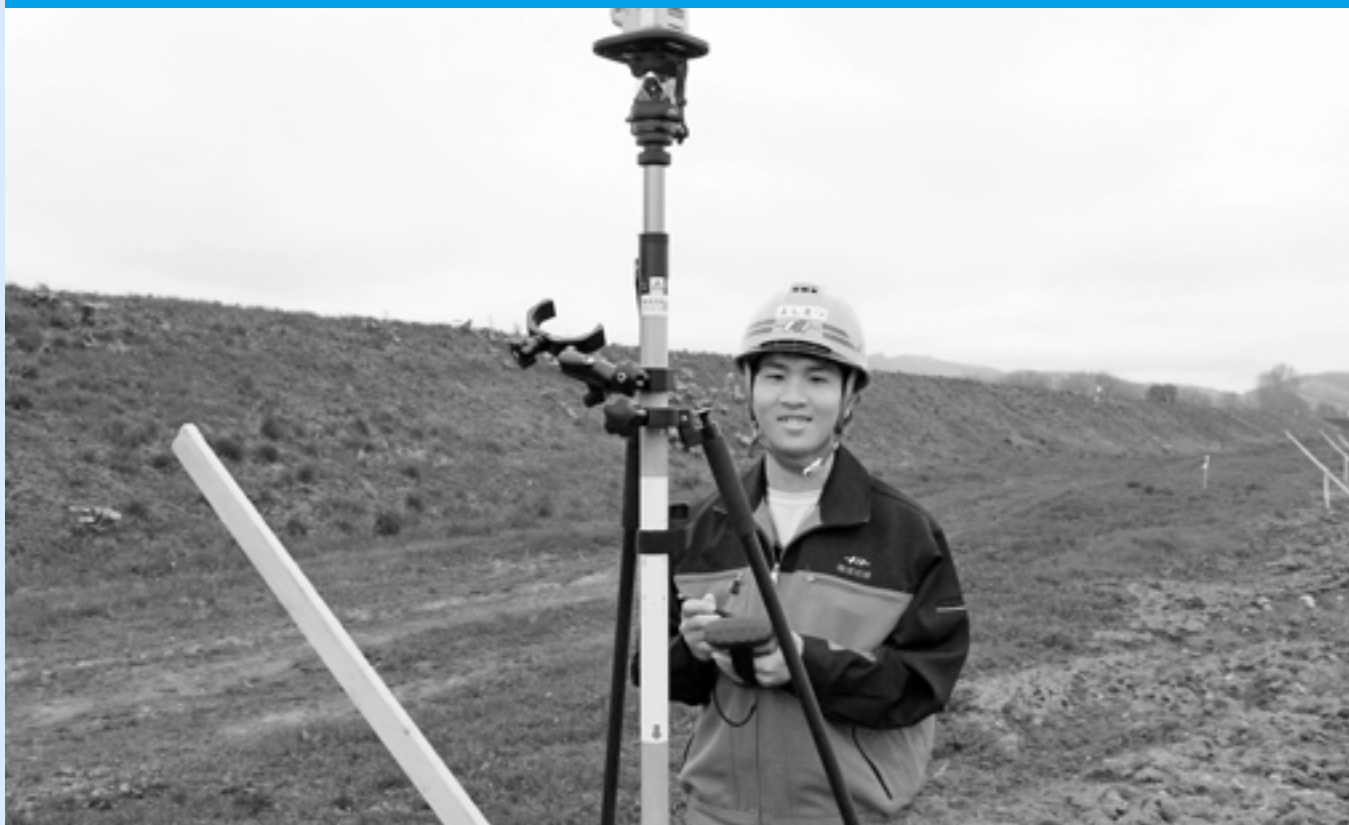
兵村の排水路工事現場で測量する吉松さん
