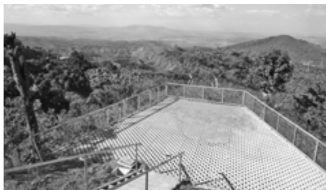
⑨ 建物の裏手は見晴らしの良い展望台となっており、完成後はパラソルを置いて軽食を取りながら景観を楽しめるという
