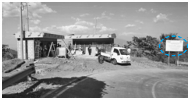
⑦ バルサモ広域市連合によって建設中の「道の駅」。峠に位置し、トイレと12台の駐車スペースの他に民芸品や食事を販売するキオスク、当地の治安情勢から観光警察駐在所も設置される予定。2017年4月オープン予定
