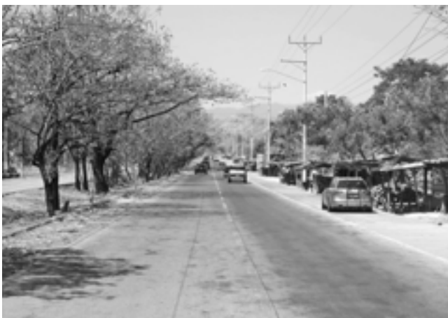
① 同国の主要幹線道路はきれいにコンクリート舗装されている。区間によっては片側2車線で植樹された中央分離帯を有するなど、よく整備されている印象を受けた。沿線では、日差しを防ぐ程度の簡素な小屋の中で地元の家によって農産物が販売されていた。道路わきに車を止める道路利用者も散見されるなど、道の駅に対する潜在的なニーズはあるように見受けられた
