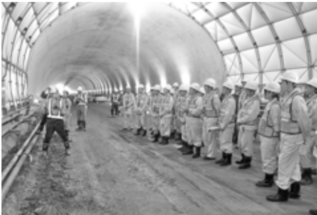
写真8 学生を対象とした現場見学会（豊郷トンネルにて）
