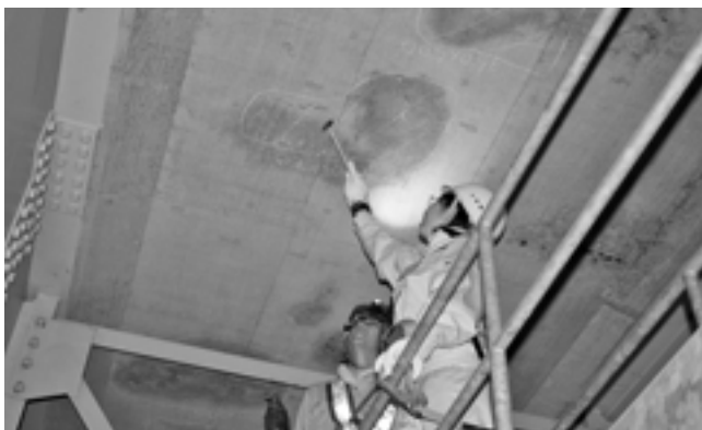
写真4 橋梁点検実習（国道235号苫東大橋にて）
