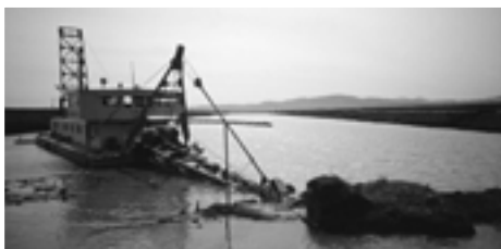
ポンプ船による篠津運河の掘削
