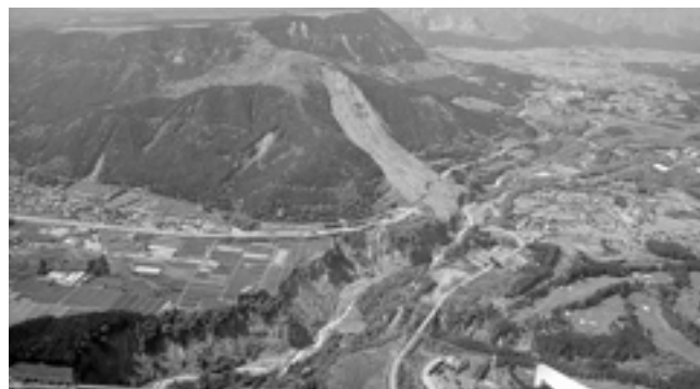
阿蘇大橋崩落現場（北陸地整災害対策用ヘリコプター「ほくりく号」より撮影）
