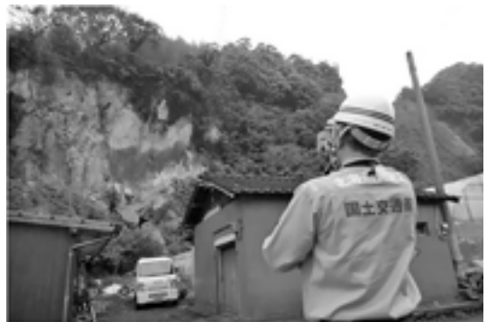
土砂災害危険箇所調査（4/25 熊本市）
