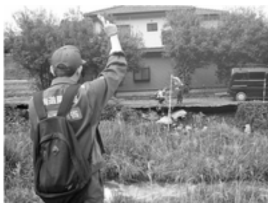
土砂崩れ箇所調査（4/26 西原村）
