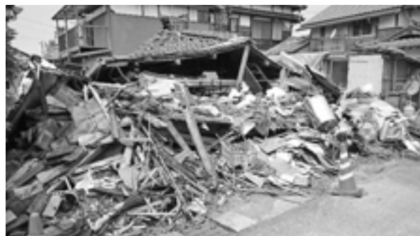
倒壊した家屋（宇城市内）
