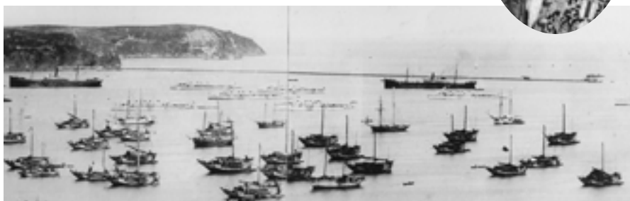
工事中の北防波堤と小樽港 (明治36年)：小樽市総合博物館所蔵
