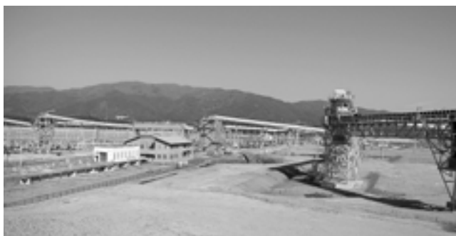
陸前高田市のベルトコンベアによる土石運搬（2014年10月）
