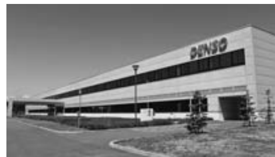
デンソー北海道の敷地面積は163,000㎡。現在の建物面積は31,200㎡だが、将来的には増設の可能性もあるという
