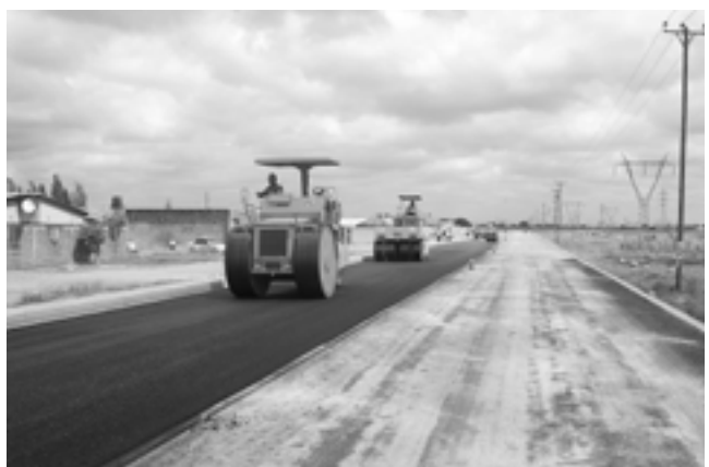
工事中のインナーリング道路
