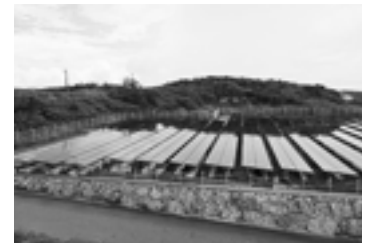
台風対策で5度に設置されている太陽光パネル
