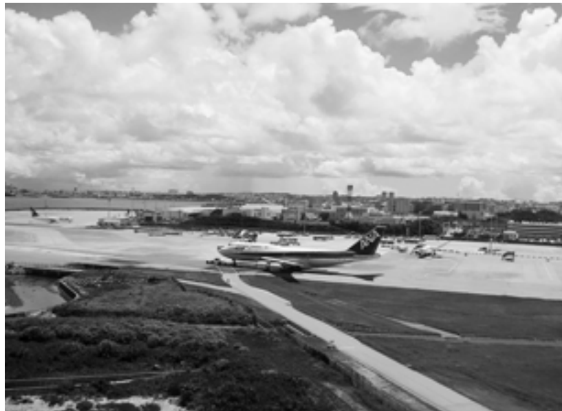
那覇空港の国際物流ハブ拠点と那覇港をのぞむ
