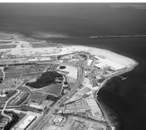
那覇空港に隣接した国際物流拠点産業集積地域那覇地区 (写真提供：沖縄県)
