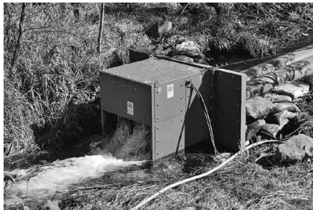
流水式と呼ばれるマイクロ水力発電の一例
