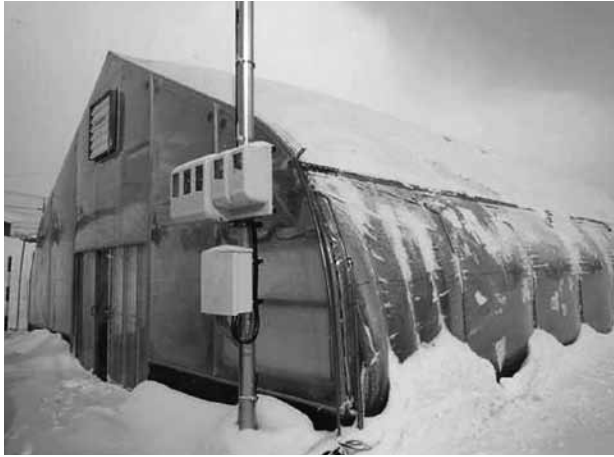
地中熱を利用した暖房システムを導入した農業ハウス。ニセコ高校に設置されている
