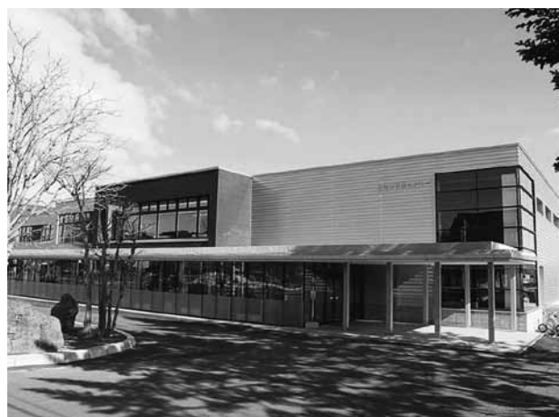
地中熱ヒートポンプを導入した町民センター。年間100万円程度の費用削減が期待できるという
