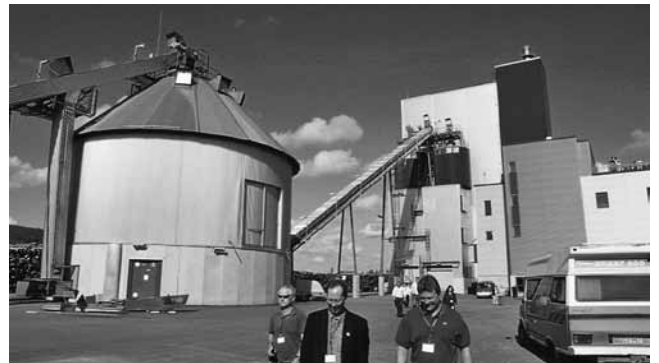
図10 ケルバ市のCHPプラント外観
