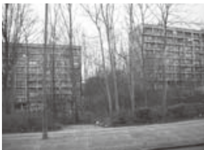
パーブランドのゲトー化した集合住宅 住棟間隔が広く、地上での状況を自然監視できない。住戸当たりの面積が恵まれているために、素行不良な移民も大家族で住むことで知られる。男性であっても屋外へのゴミ出しが危険なためダストシュートが採用されている。デザインが誘発する犯罪。
