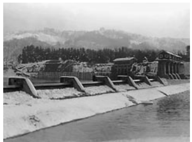
北海幹線用水路。赤平から南幌町まで約80kmにおよぶ日本一長い農業専用の用水路。1924年に着工、4年と4カ月で完成した。いくつもの川を渡るため水路橋や逆サイフンの難工事を克服した。美瑛市には調整池、岩見沢市など市街地では親水公園が整備されている。2004年、将来に引き継ぐ「北海道遺産」に選定された。(写真提供: 北海道土地改良区)
