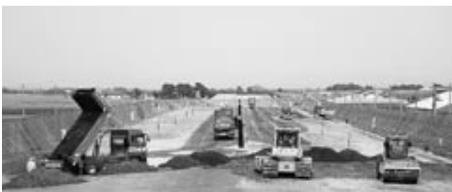
道央圏連絡道路（美原道路）
