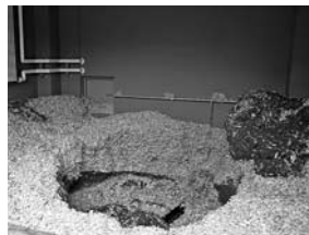
木質バイオマス施設の内部。チップとパークを混合させ、ボイラーに投入される
