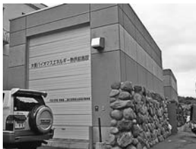
五味温泉の木質バイオマス施設。冬季に内部がマイナス気温にならないように配慮して設計された
