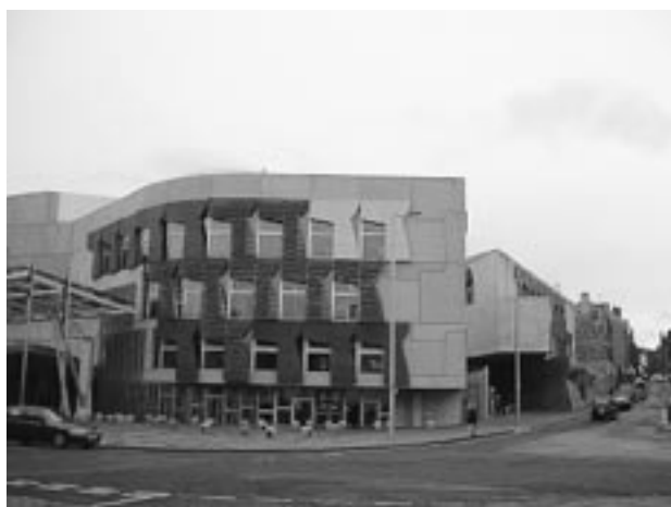
新議会棟の正面入口
