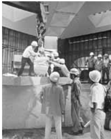
草月会館天国工事（撮影：野口ミチオ）
