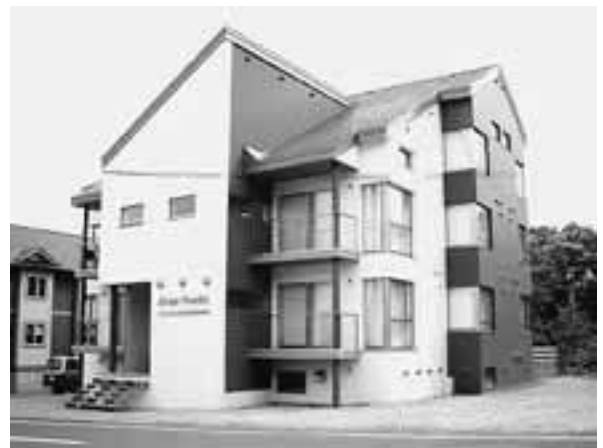
2棟目の Condominium 「Deep Tracks」
