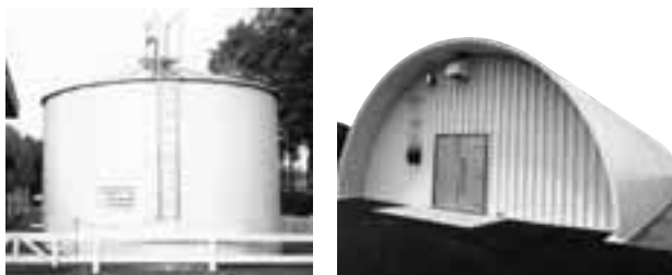
社内で換気冷房として活用しているアイスシェルターと、農産物貯蔵用のアイスシェルター
