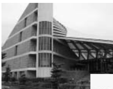
上屋久町にある「屋久島環境文化村センター」は屋久島に関する総合的な情報の提供、交流、案内の拠点施設。
