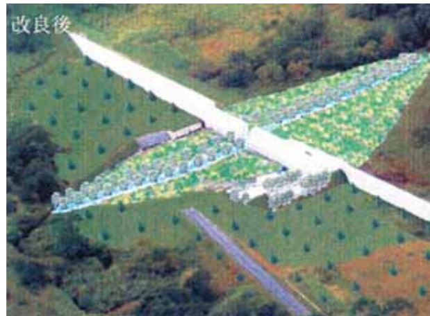
自衛隊演習場内でイトウ繁殖地を直撃する形で建設された砂防ダム(上の写真、撮影筆者)。札幌防衛施設局は2006年、堤体にスリットを入れて復元を図ると公表した(下のイラスト。矢白別演習場・別寒辺牛川水系土砂流出対策等検討委員会「矢白別演習場・別寒辺牛川水系土砂流出対策等に関する最終調査報告書(案)」から引用)。
