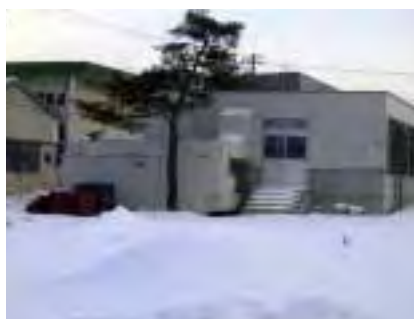
道立岩見沢農業高等学校農業土木工学科の鶏舎の夏季雪冷房
