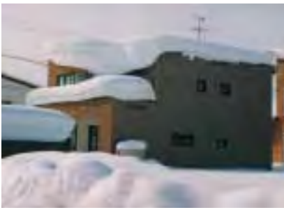
防寒性能の向上した住宅に形成された雪庇 (旭川市内の住宅地)
